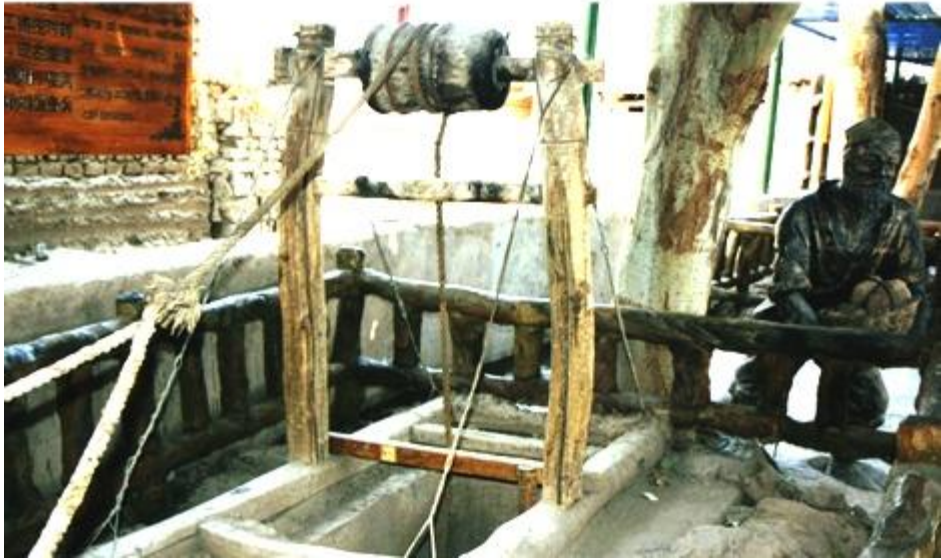
Resim 8: Doęu T¼rkistan'ın Turfan Ovasındaki Karız kanalları unsurları (Kanal, suyun yer ¼st¼ne ıktıęı yer, Karız bakım kuyusu) (Kaynak: Kadir Tosun , 2012)
